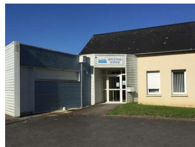
Centre de Château-Gontier 8 rue du Poitou Bazouges 53200 CHATEAU-GONTIER
